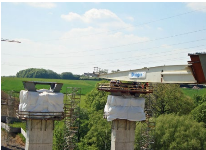
Bild 14. Auflaufen des Vorbauschnebels am Pfeiler 30 (Foto: 2013 Donges Steeltec GmbH) Fig. 14. Surge on the pillar 30
