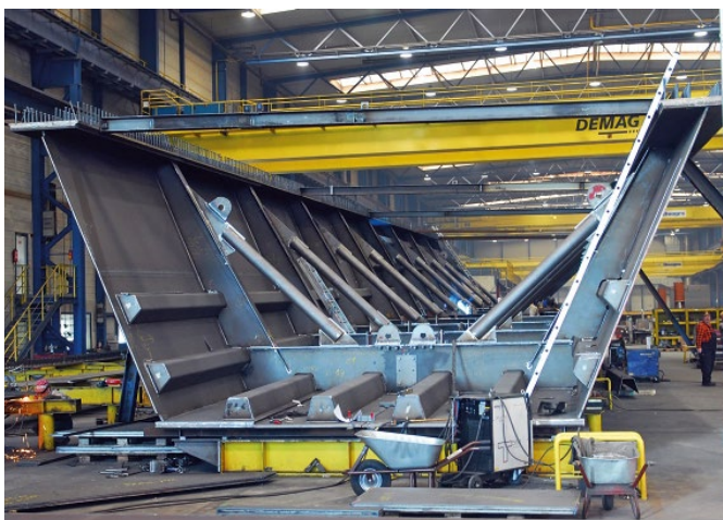
Bild 4. Werkstattfertigung Gesamtquerschnitt Regelbereich (Foto: 2013 Donges Steeltec GmbH) Fig. 4. Manufacturing regular cross-section
