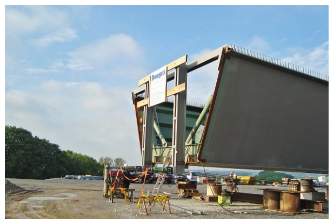
Bild 13. Litzenhubsystem am Überbauende (Foto: 2013 Donges Steeltec GmbH) Fig. 13. Lifting-system at end of superstructure
