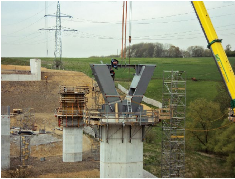
Bild 11. Montage der Pfeilerstreben (Foto: 2013 Donges Steeltec GmbH) Fig. 11. Erection of the pillar-area
