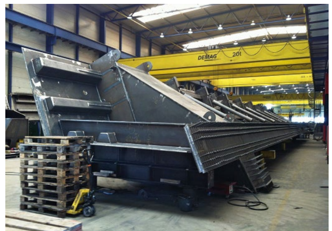
Bild 5. Werkstattfertigung Pfeilerquerschnitt (Foto: 2013 Donges Steeltec GmbH) Fig. 5. Manufacturing pillar-section
